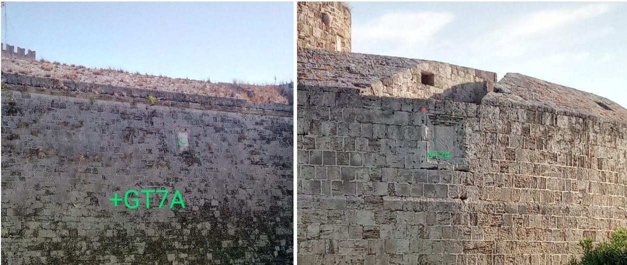
Σχήμα 5 - Παράδειγμα χρήσης σταθερών σημείων ως σημείων ελέγχου
